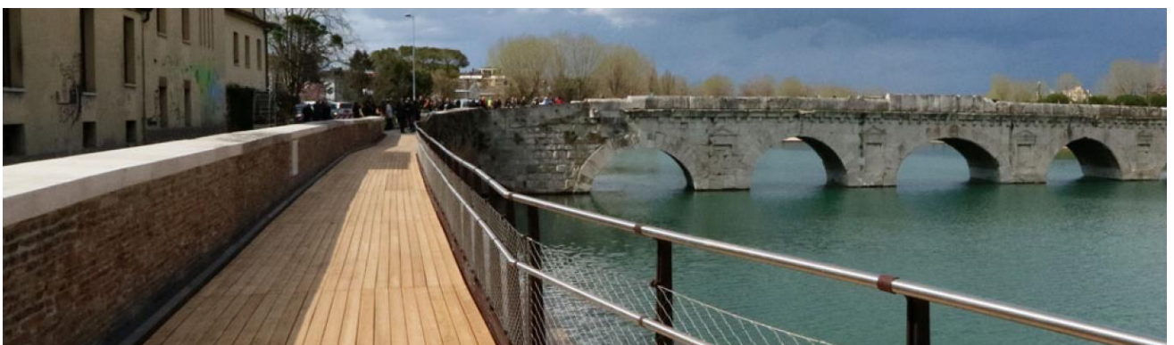
Figura 8 -Passerella pedonale e ciclabile realizzata dalla parte della città
