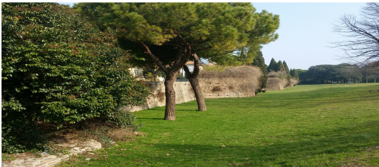
Figura 15 – Mura cittadine di via Bastioni Orientali
