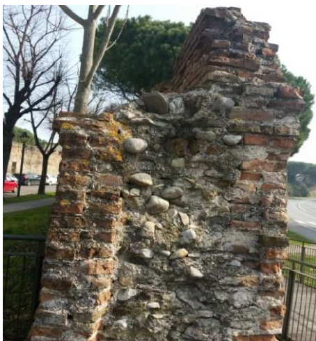
Figura 20 - Sezione di muro interrotto
