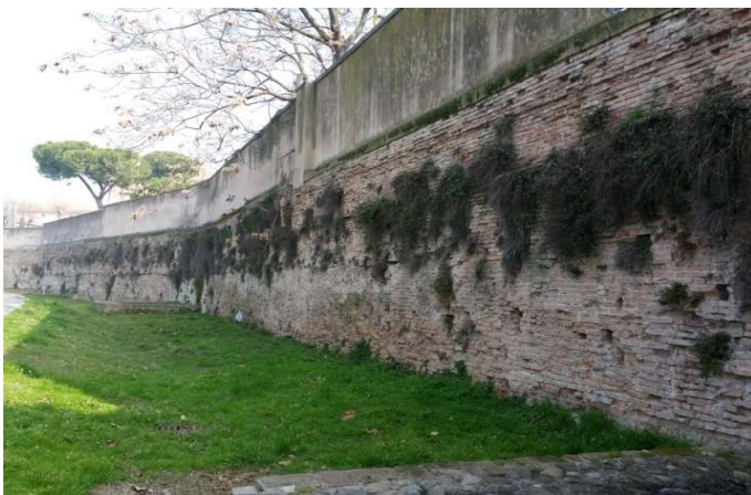
Figura 24 - Mura cittadine in prossimità del Ponte di Tiberio
